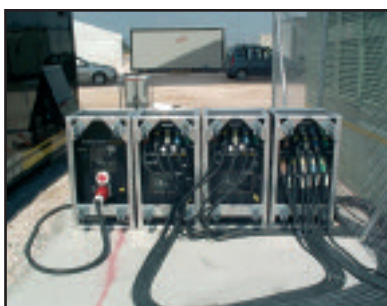
Главное распределительное устройство 400А для рок-концерта.
