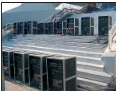
Гл.распределительное устр-во на 630А для Международного трансляционного центра (МТЦ) на Олимпийский играх.
